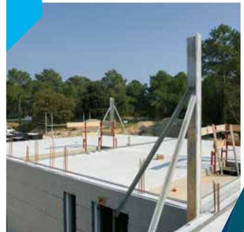
Pose sur élévation
