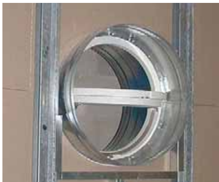
ISONE+/Ap en cours de montage
