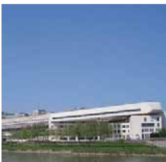
Hôpital de Nantes, France.
